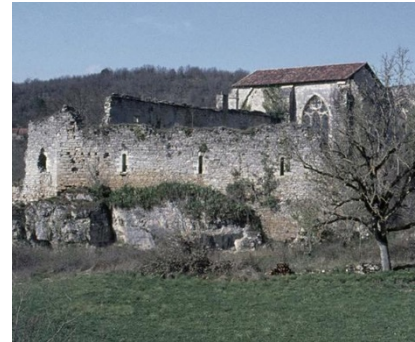
Photo 50 : Abbaye nouvelle, commune de Léobard (classée MH) - Ministère de la Culture (France), Médiathèque de l'architecture et du patrimoine, diffusion RMN-GP
